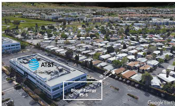
AT&T Data Center | USA
