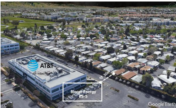
AT&T Data Center | USA
